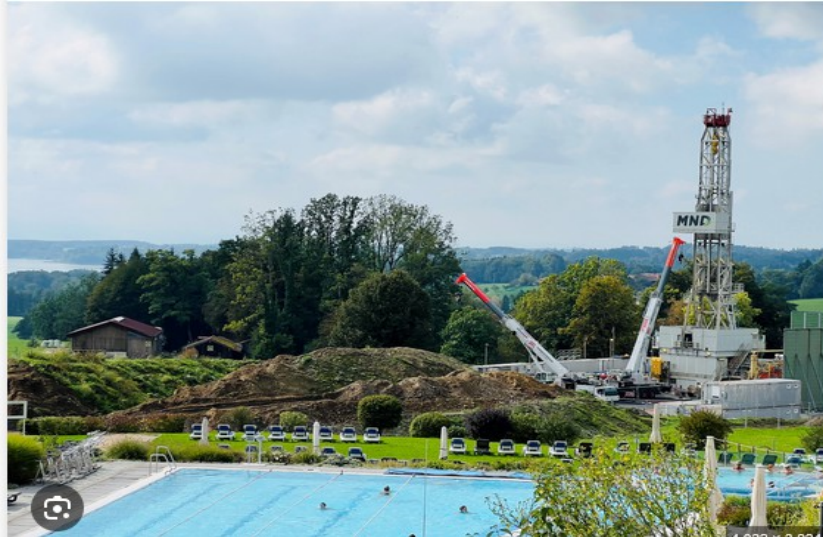
Sanierung Bohrung Endorf II begonnen
